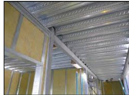
**El steel frame ecológico** es un sistema de construcción ligero y sostenible. Utiliza acero reciclado, reduce el desperdicio y mejora la eficiencia energética. Su diseño modular permite una rápida instalación, garantizando durabilidad y bajo impacto ambiental en proyectos de construcción responsable.
